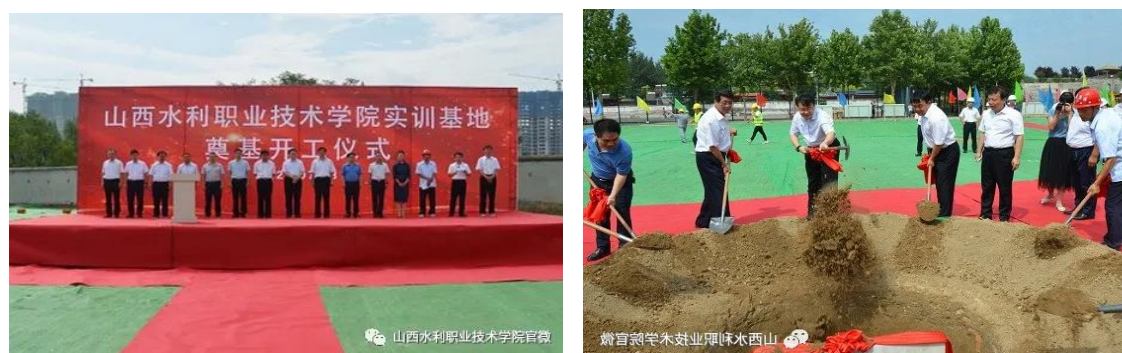
图 34 产教融合实训基地项目开工
